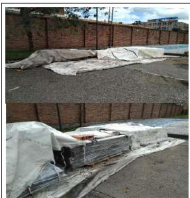
**Fotografía 7. Acopio interno de tejas de asbesto**
